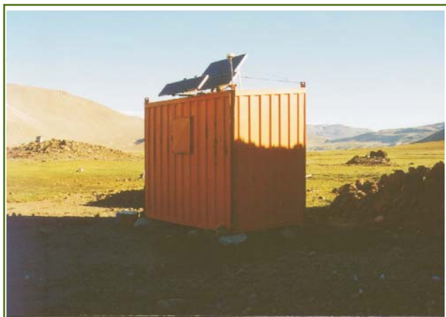
Figura 2. Habítaculo donde se instalaron los equipos de EA y los paneles solares
